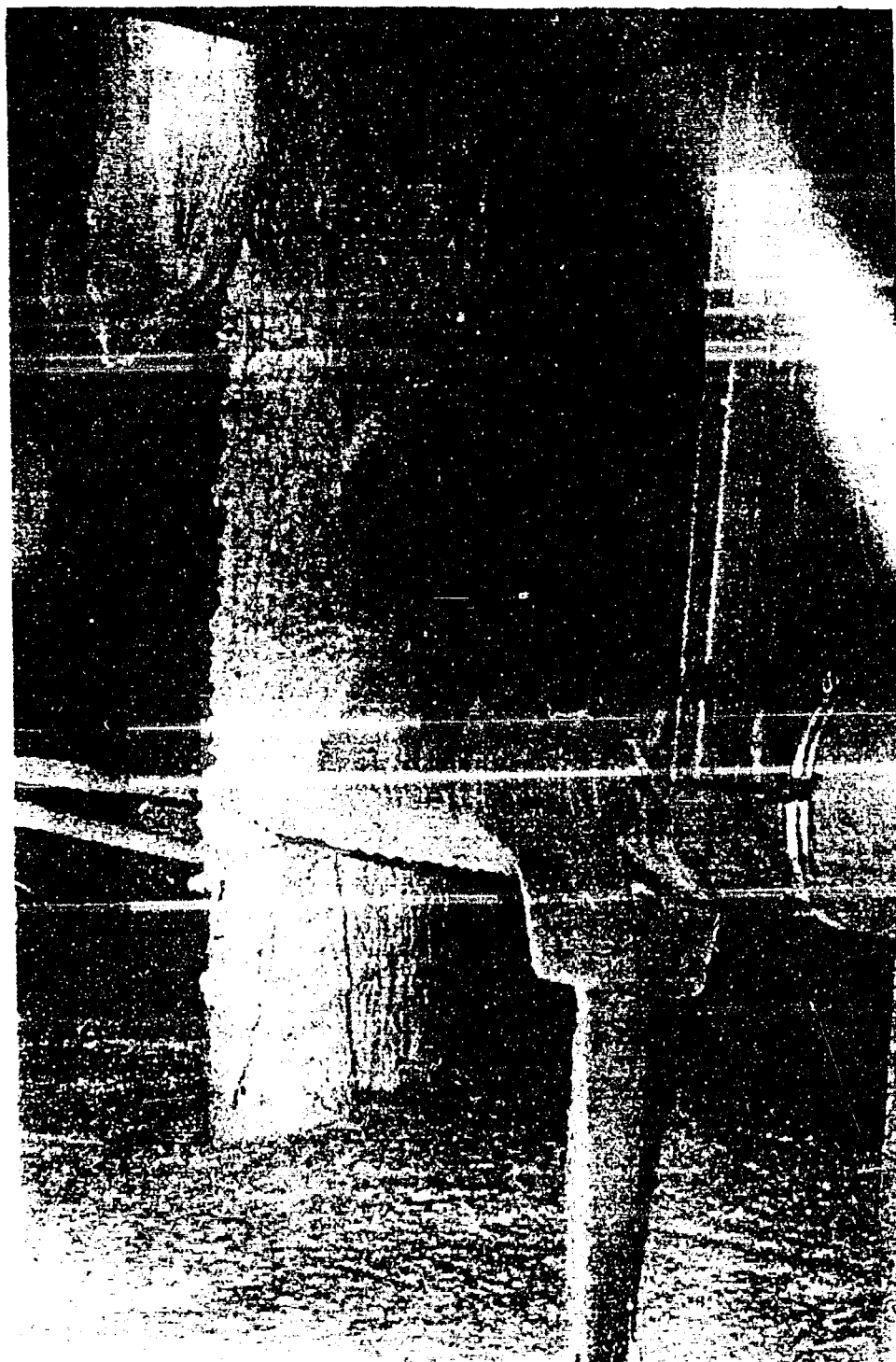
РИС. 11. БАССЕЙН-ВАРЬОТЕР, УТМ. 2.20, ПОМ. 012/13. ОСЛАБЛЕННАЯ ТРЧБА В ЗОНЕ ОСИ Д, ПОКРЫТАЯ НАТЕКАМИ МЕТАЛЛА.
